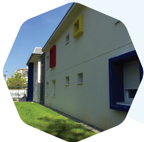
Mosaïques Centre Maternel Majeures 3 rue Thiers 68052 Mulhouse
